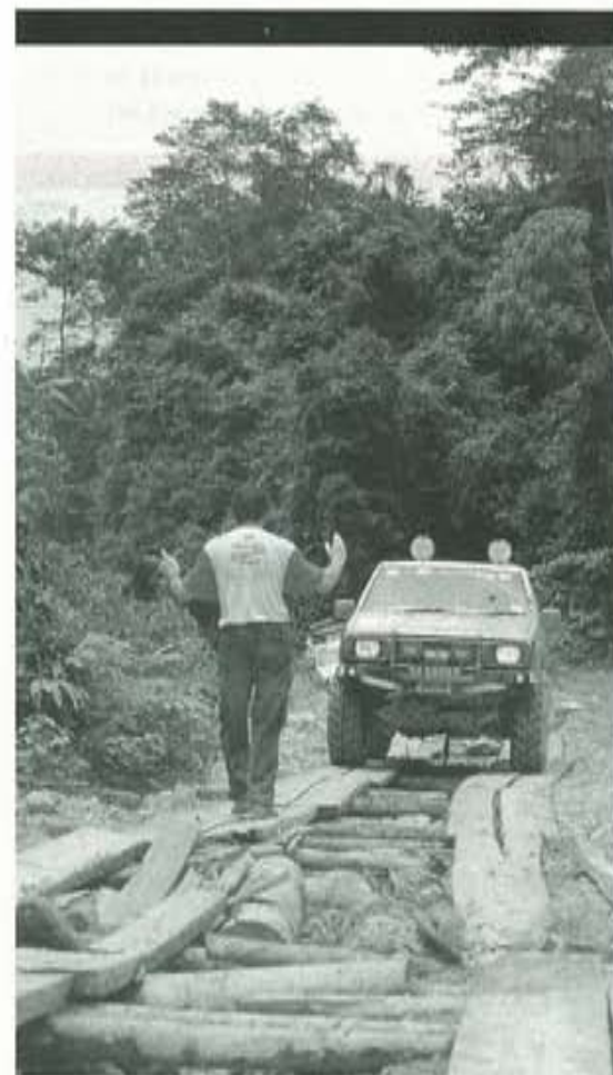
Stap je voor stapje worden de auto's over de gammele houten brug geloosd.
